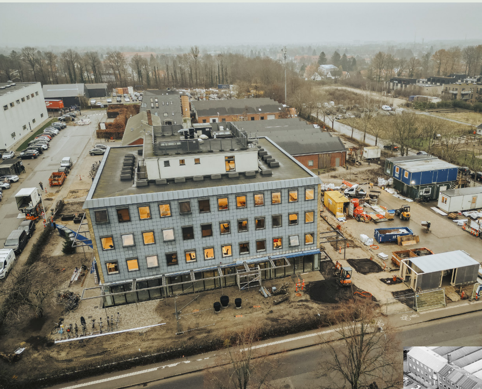
Fondenes domicil har i 2024 og 2025 gennemgået en renovering og modernisering. Dronefoto fra december 2025.
